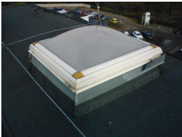
zdj. nr 1 klapa oddymiająca – Pawilon C
